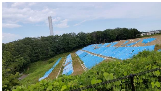
峠谷地区（斜面部）
