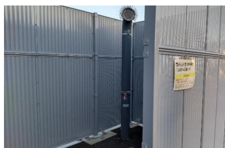
写真7 ガス抜き管 （池の辺地区）
